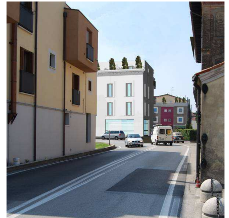
Vista arrivando da Cessalto
