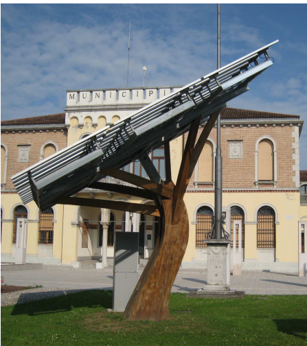
L'albero fotovoltaico di Ceggia
